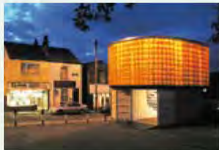
Cratehouse for Castleford instalación temporal, Castleford Inglaterra 2006 – 2009
